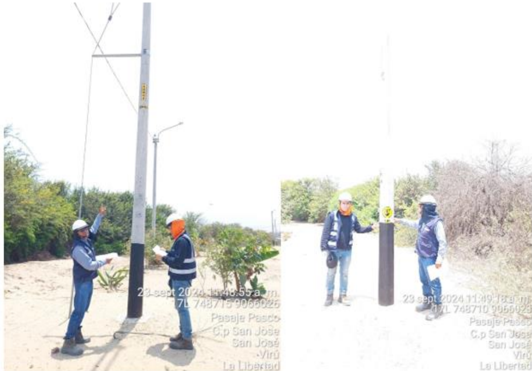
FOTO N° 01: VERIFICACIÓN DE CODIFICACIÓN DE POSTES DE RED SECUNDARIA Y SEÑALIZACIÓN DE PUESTA A TIERRA.
