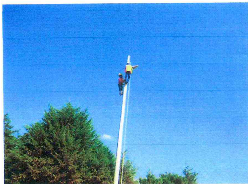
Fraguado de Ménsulas De 1.00m, Línea De 22.9kv
