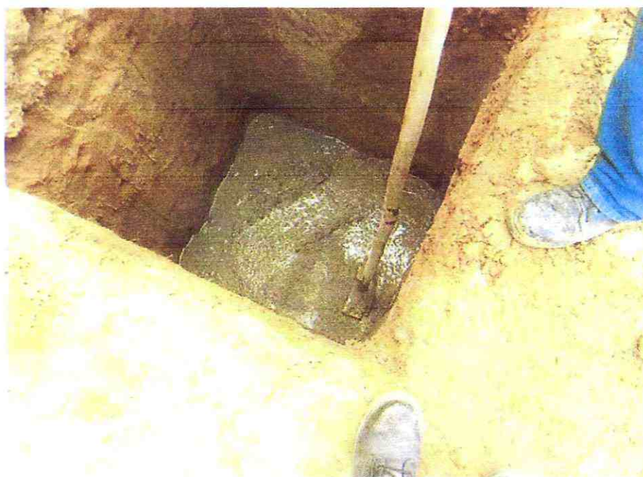
Construcción de solados para la línea de 34.5kv, preparados para el izamiento de los postes de 15/400.
