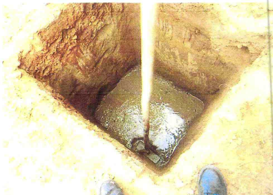
Construcción de solados para la línea de 34.5kv, preparados para el izamiento de los postes de 15/400.
