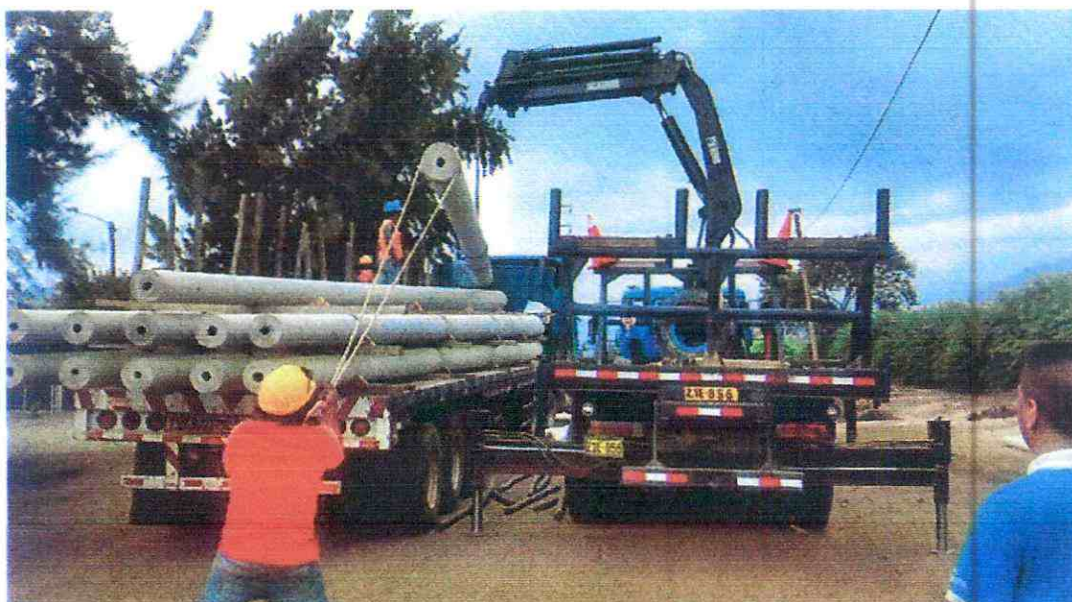
Postes para la Línea de 34.5 Kv.
