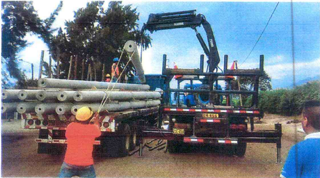
Bajada de postes con grúa.
