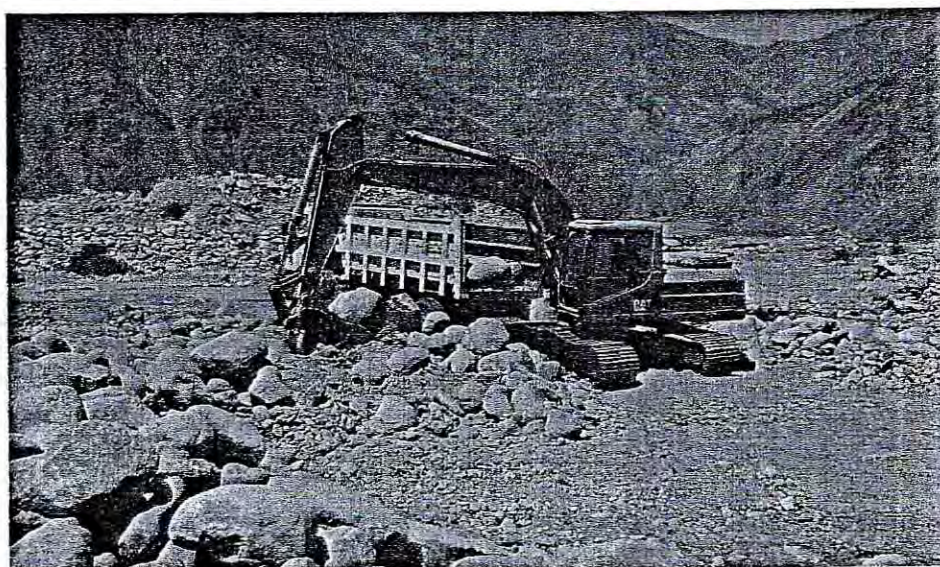
Extracción de roca por medio de retroexcavadora y colocación en camión volquete para su traslado a la protección del conducto cubierto.
