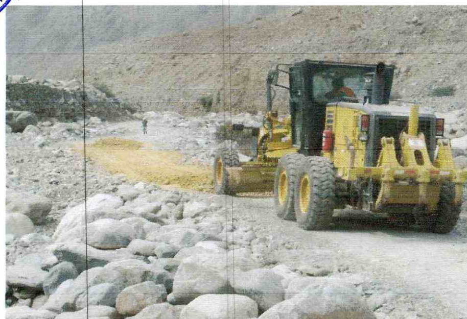
SE OBSERVAN LOS TRABAJOS DE MEJORAMIENTO DE CAMINO DE ACCESO
