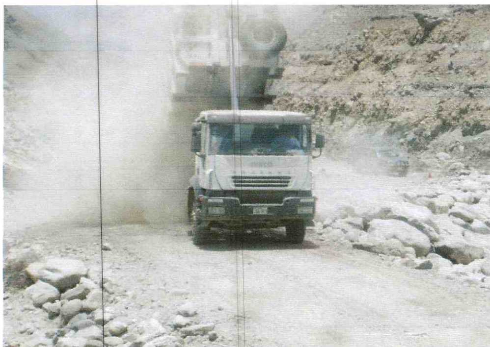
SE OBSERVAN LOS TRABAJOS DE TRANSPORTE DE ROCA PARA ENROCADOS
