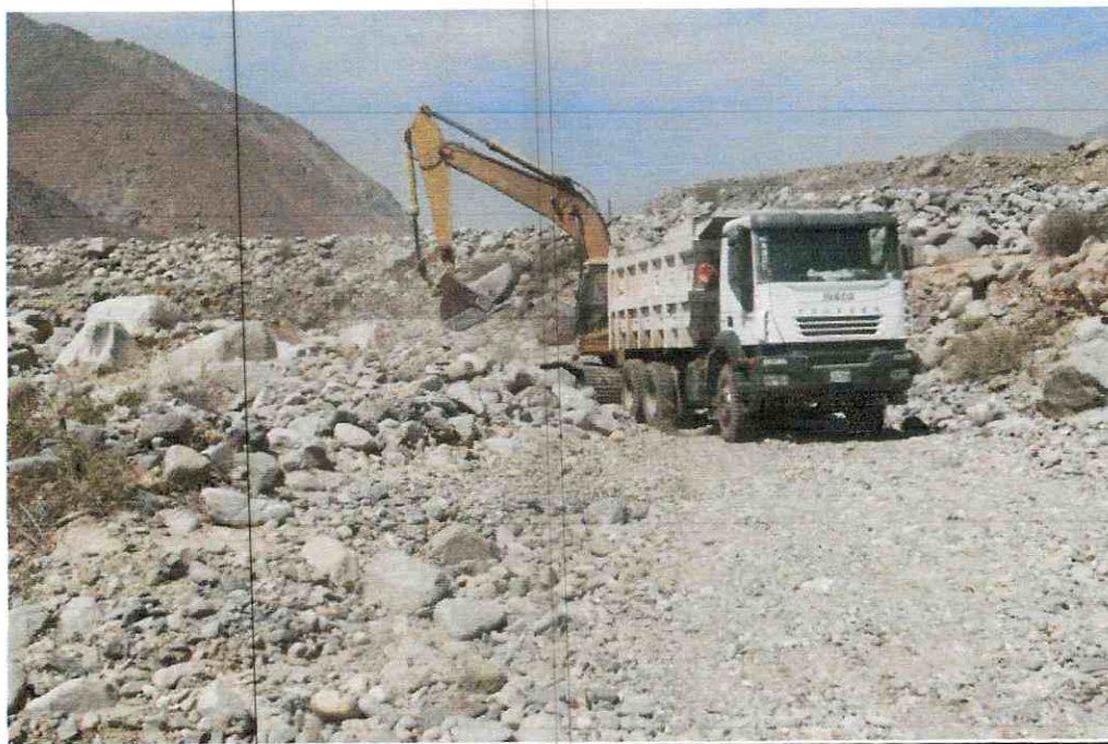
ACOPIO DE ROCA PARA CONFORMACION DE ENROCADO EN CONDUCTO CUBIERTO
