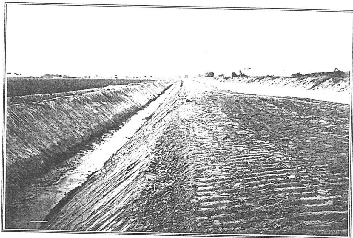
FOTO NO 2 : Nótese la explanación de material en la margen derecha que corresponde al camino de servicio del dren.
