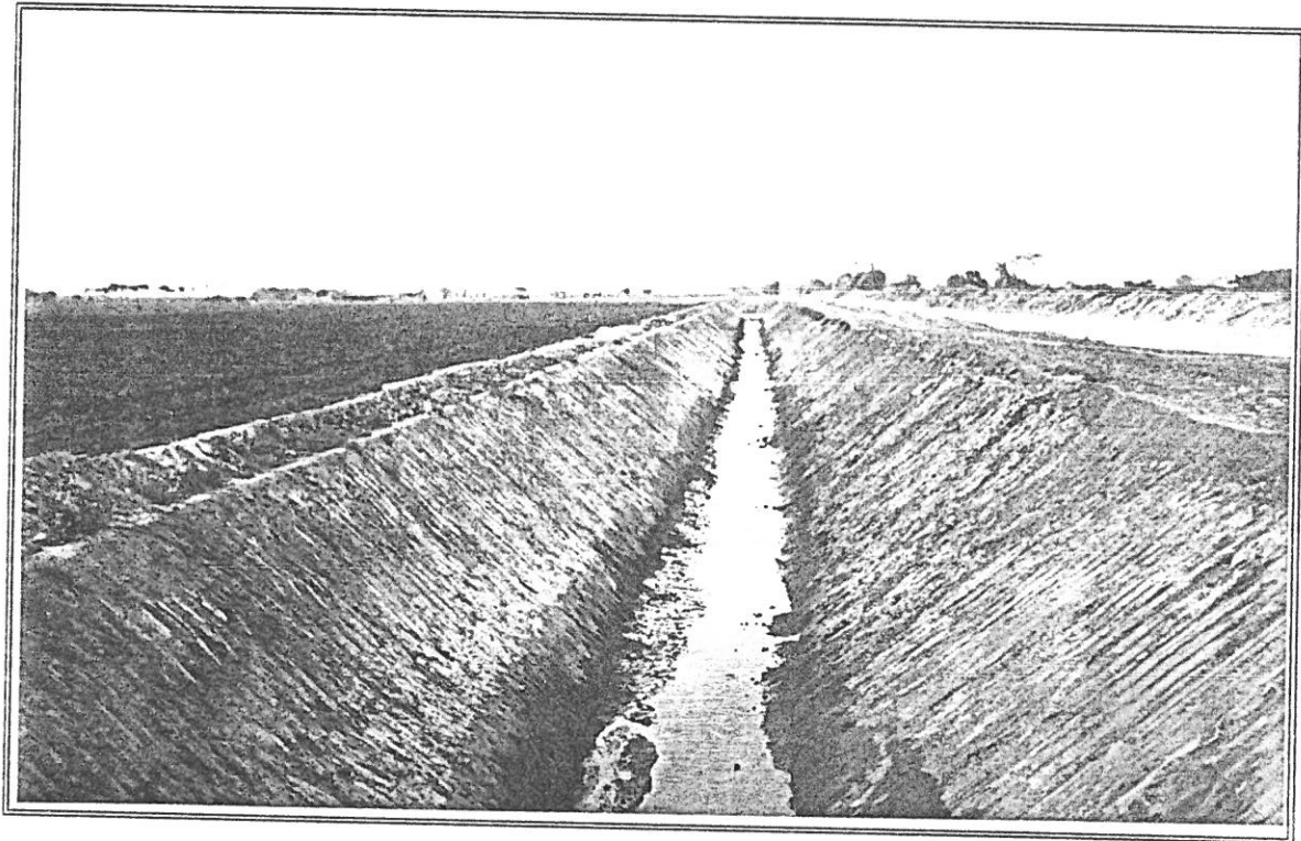
FOTO NO 2 : Nótese la explanación de material en la margen derecha que corresponde al camino de servicio del dren.
