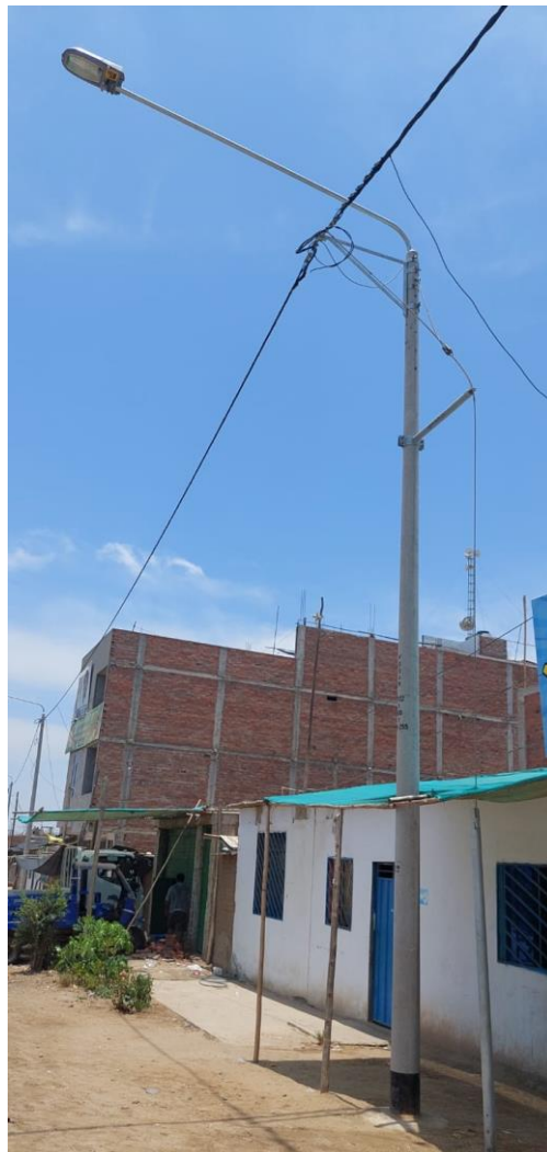
5.- Distanciadores instalados y pastorales de 3.2 /1.5 para luminarias de 150 whatts
