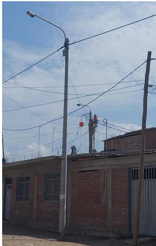
9.- Luminarias instaladas y conexionado de redes (devanado) y cajas de derivacion
