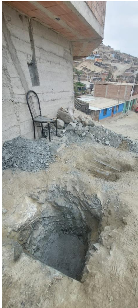
1.- Apertura de hoyos para poste y retenida en terreno rocoso
