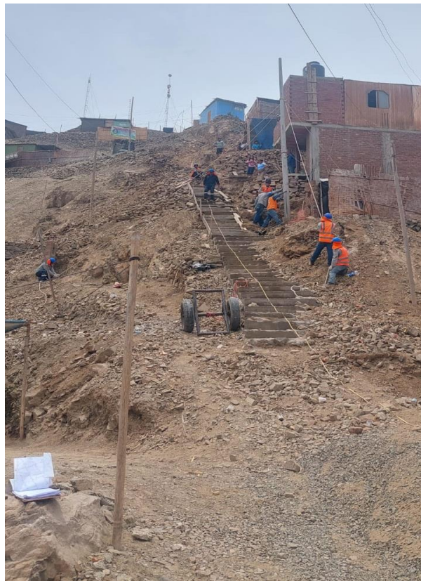
3.- Traslado de postes e izaje manualmente
