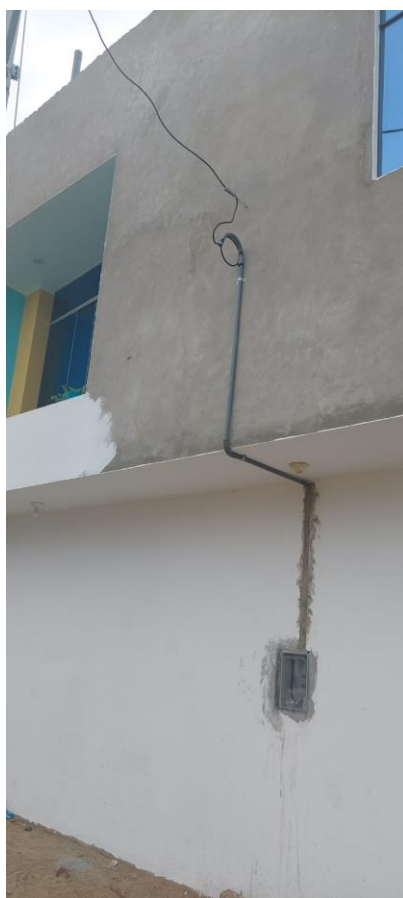
6.- Señalización para resinto de caja portamedidor e instalacion de Acometidas domiciliarias con codos de PVC
