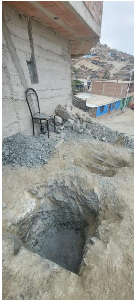
2.- Apertura de hoyos para puesta a tierra en terreno rocoso
