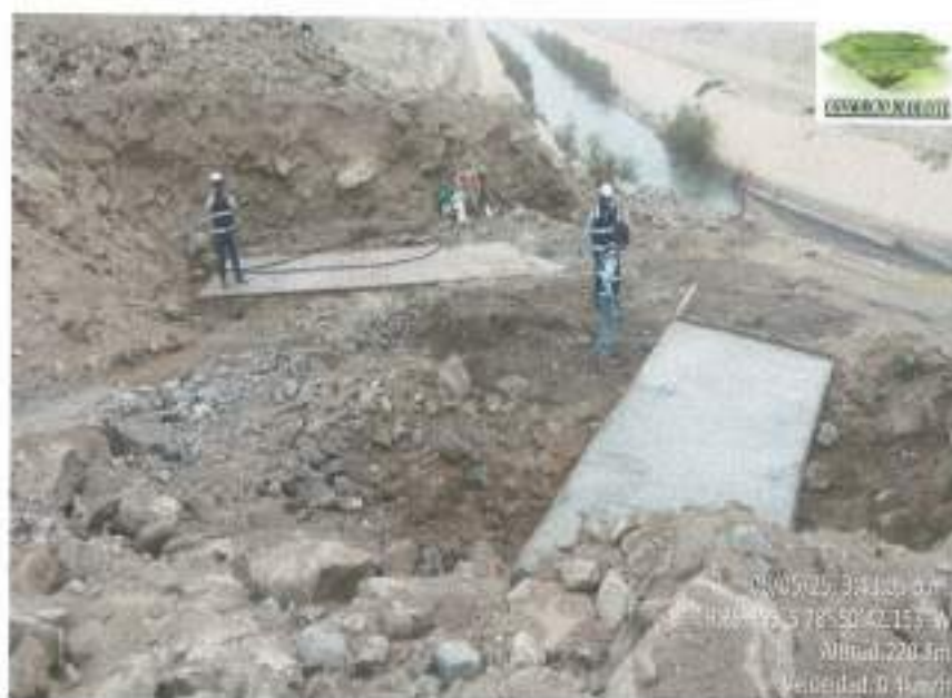
FOTO N° 08: Verificando limpieza de concreto después del vaciado.
