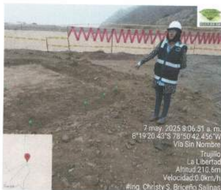
FOTO 10: El 07/05/2025 se verifico la colocación de capuchones a varillas expuestas de Yugoslavia y la Rinconada para los trabajos de trazos y replanteo.
