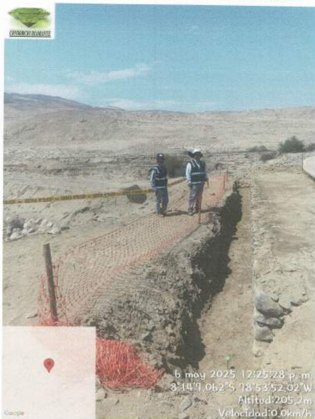
IMAGEN 3: COMPACTACION DE FONDO DE ZANJA PARA ESTRUCTURA SECTOR LA RINCONADA.
