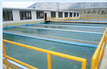
Batería de Filtros
